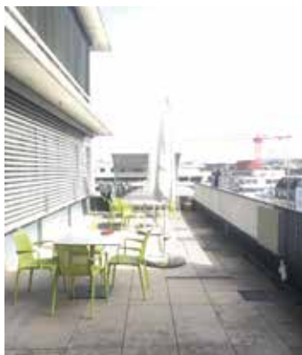
Wenig einladend: die Terrasse vor dem Umbau
