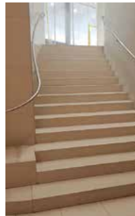
Achtung, Stolperstelle! Das Geländer führt sehbeeinträchtigte Personen nicht bis zum Ende der Stufen.
