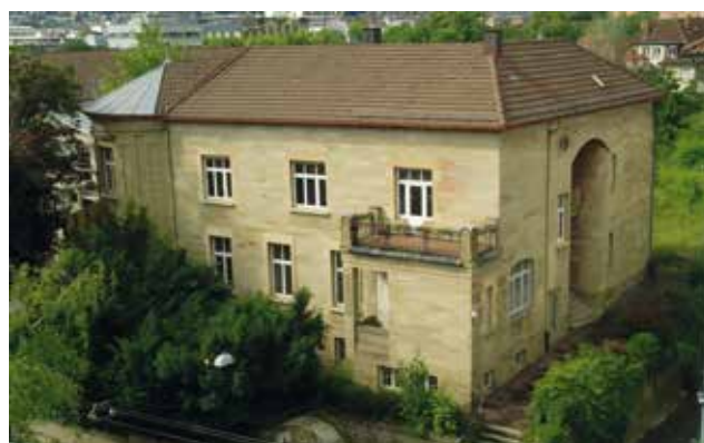
Das Herdweg-Palais vor dem Umbau
