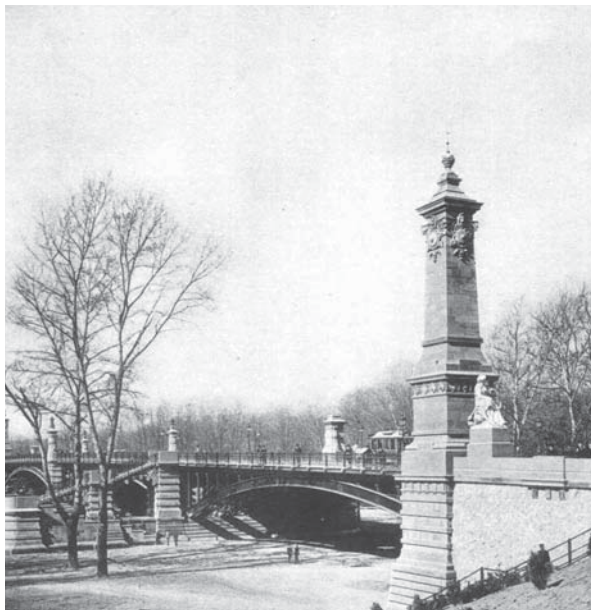
König-Karls Brücke in Stuttgart Bad Cannstatt (1895)
